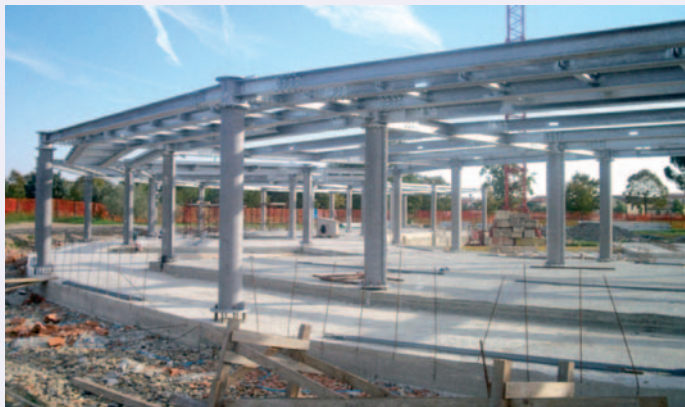
Una fase della costruzione
