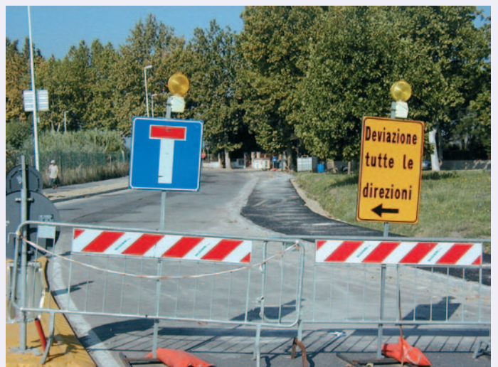
Un momento dei lavori per l'asfaltatura
