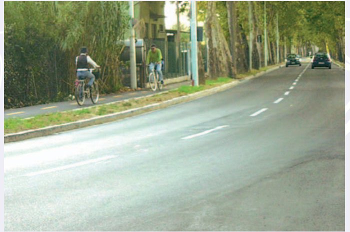
Via CIULLI dopo i lavori di asfaltatura con pista ciclabile
